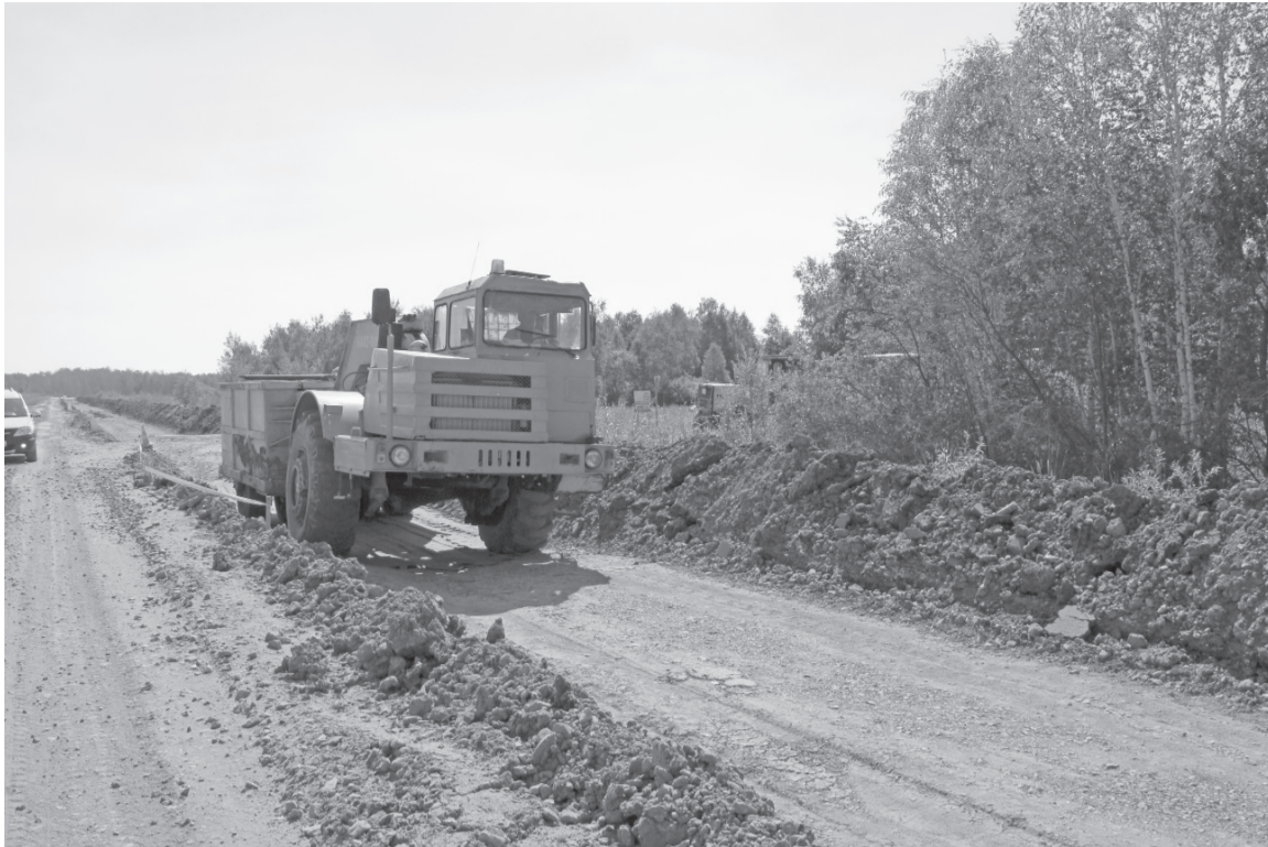
Специалисты дорожной службы фрезеруют участок дороги, подлежащий ремонту.
