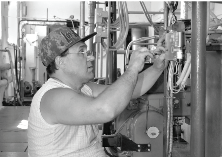
В лопазновской котельной завершается ремонт.
