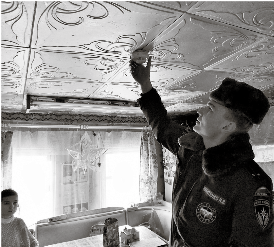
* Инспекторы ОНД проводят периодические проверки в жилом секторе по соблюдению гражданами правил пожарной безопасности.
