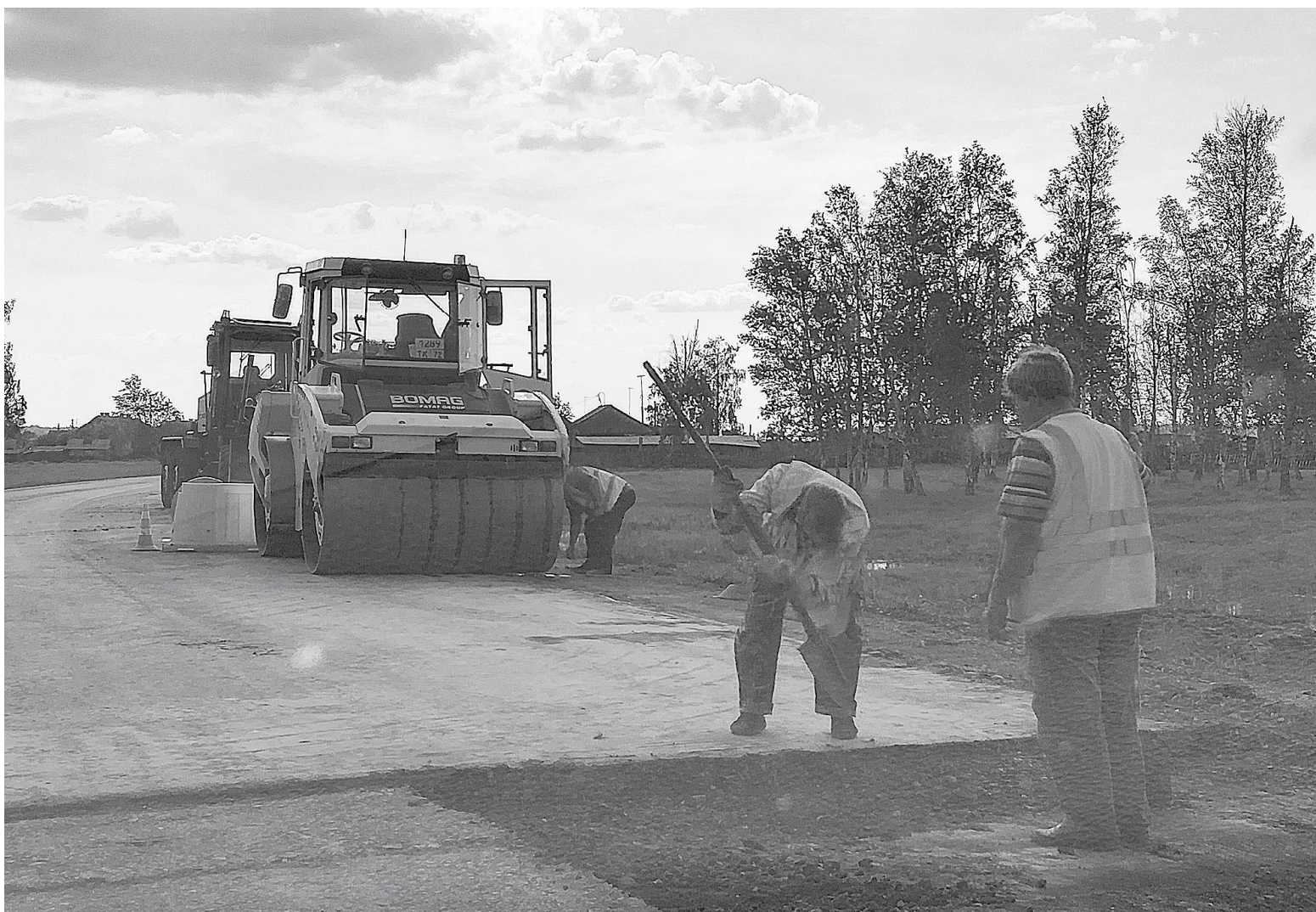
Ремонт участков автодороги Водокачка — Менжинское — Усово — Сладково — Александровка.
