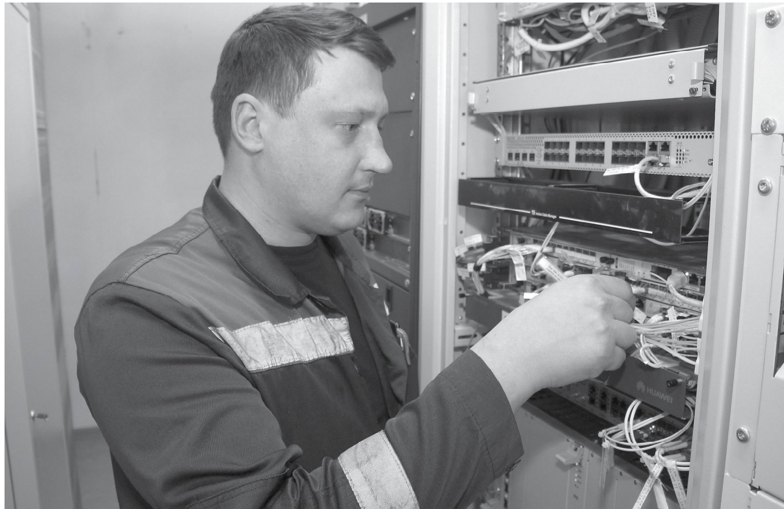
А.Кривцов, сотрудник ПАО «Ростелеком», проводит подключение оптоволоконной линии.
