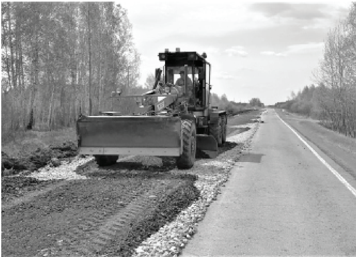
Новое асфальто-бетонное покрытие появится на дорогах Сладковского района.
