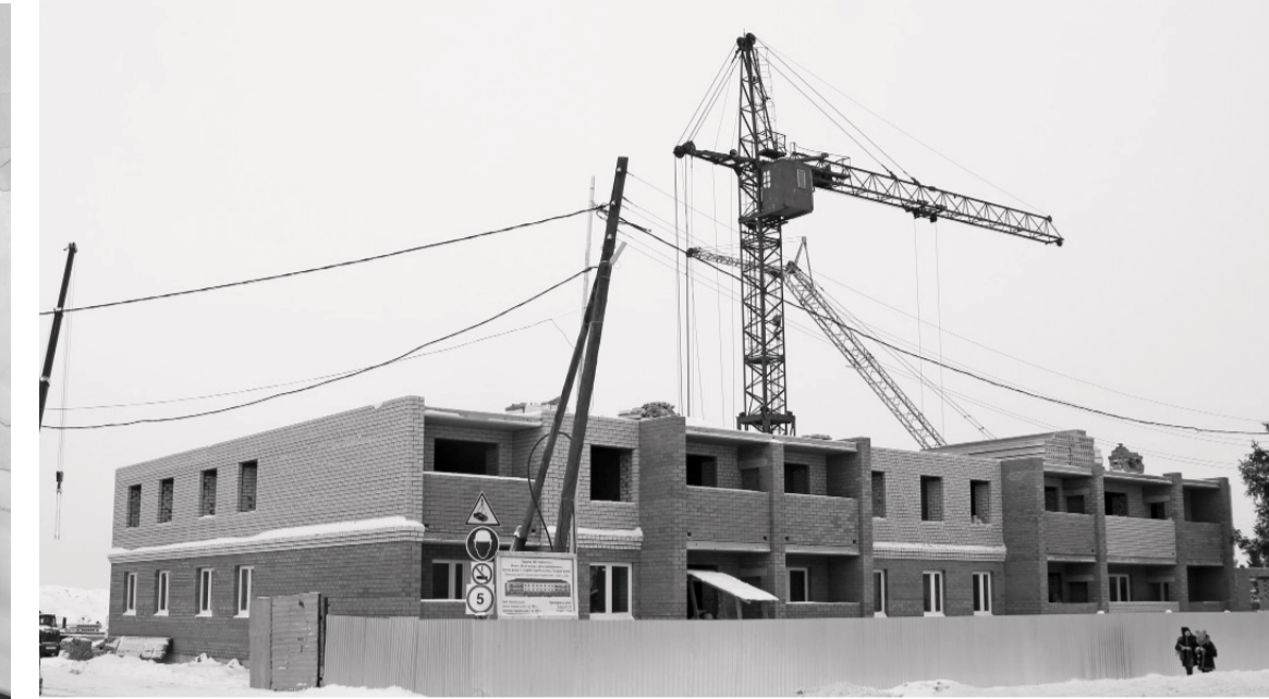
В с. Сладково строятся трёхэтажные дома.
