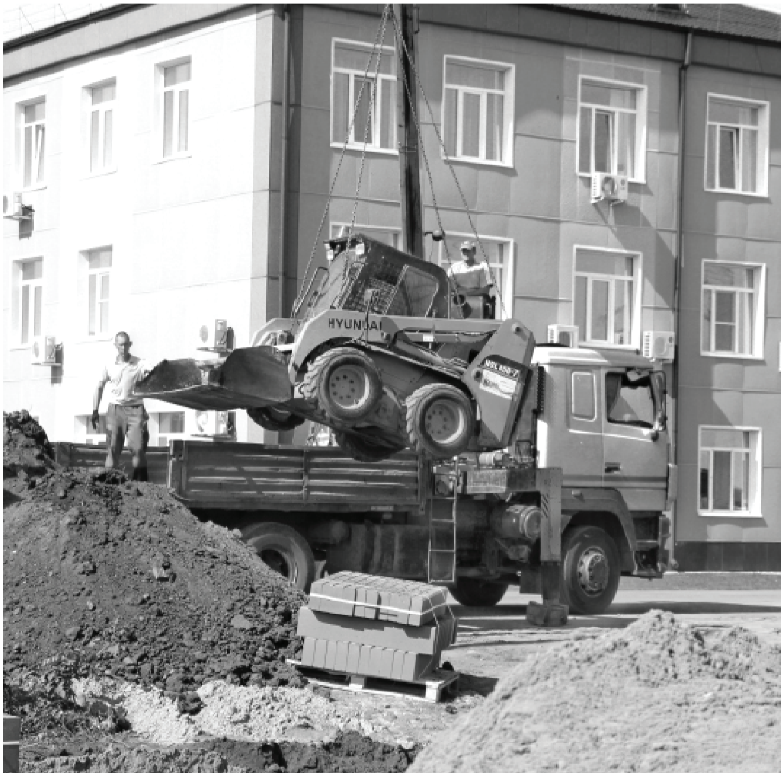
Специалисты ООО «Стройпроект» работают над созданием сквера в селе Сладково.
