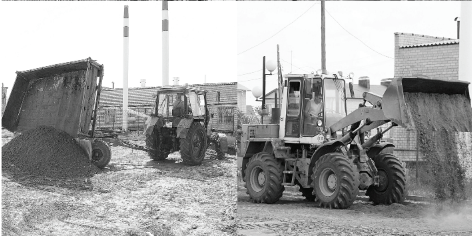
Сотрудники Маслянского ДРСУ-5 наносят асфальтобетонное покрытие на территории спортивного объекта.
