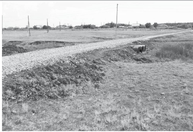
* Дамба укреплена, водоотвод усилен.
